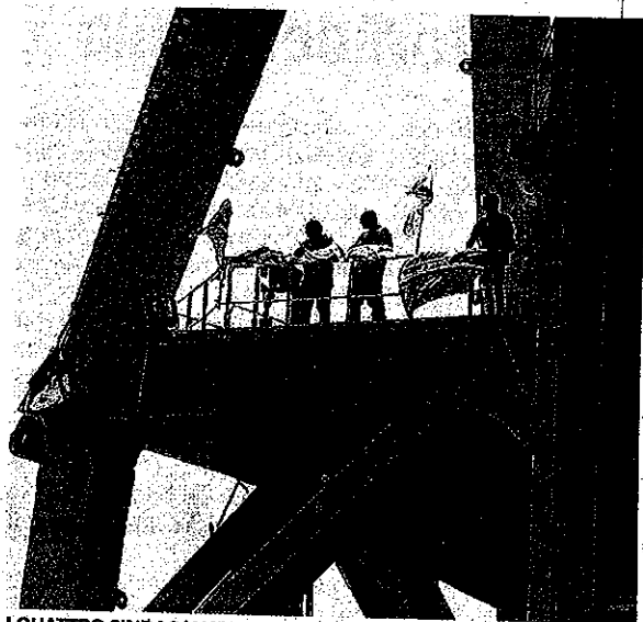
I QUATTRO SINDACALISTI SULLA GRU DEL CANTIERE NAVALE
