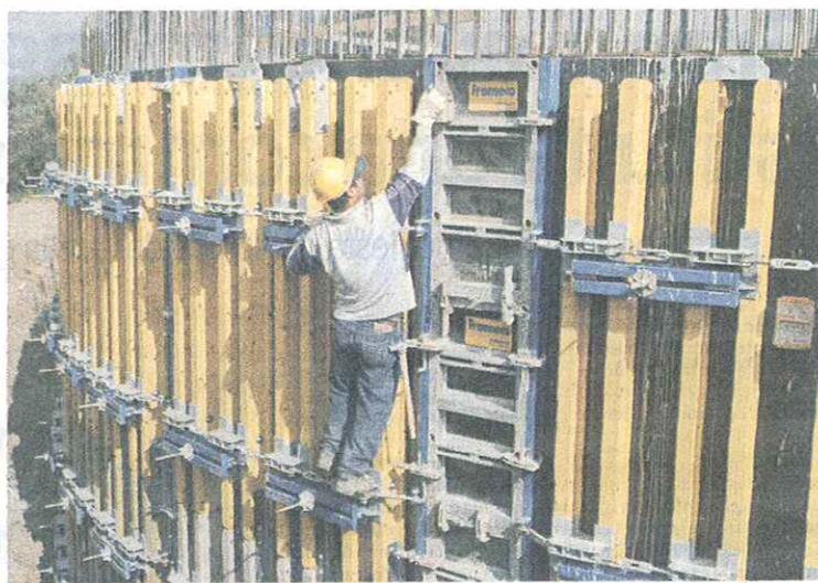
Un operaio al lavoro in una condotta idrica
