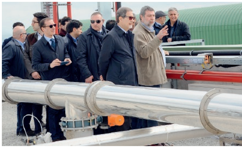
IL SOPRALLUOGO ALLA DISCARICA DI COZZO VUTURO
