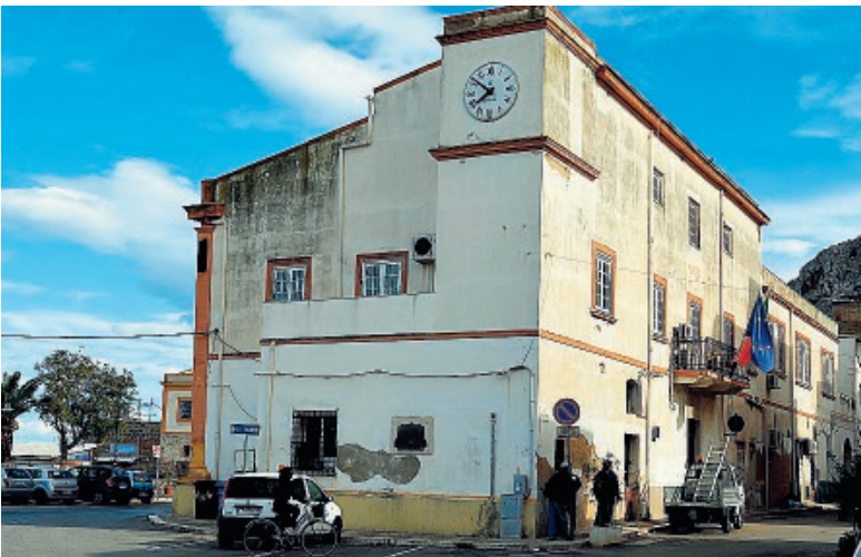
Isola delle Femmine. Il palazzo municipale di via Colombo
